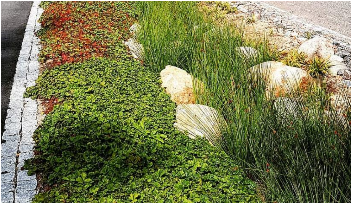
Kuva 14. Hulevesiä viivyttävä kasvillisuuspainanne
